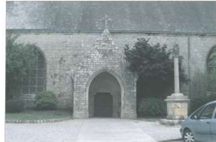
Vue générale Sud de la porte abritée sous le porche moderne
