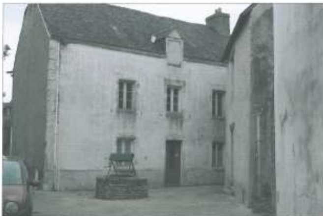
Rue Traversière, puits commun à plusieurs maisons du XVIII e siècle
