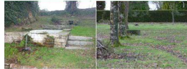
Figure 21 : Lavoir située au Moustoir à gauche et puits situé à Bel Air à droite
