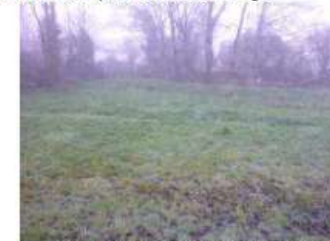
Figure 31 : bassin d'orage dans le bourg de Pluvigner
