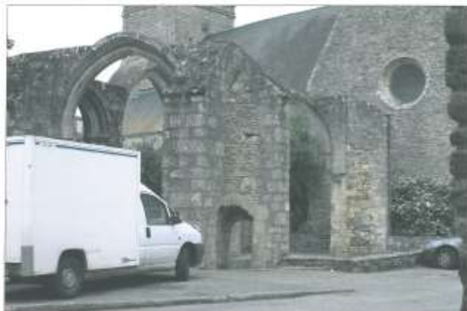
Vue générale Sud-Est des vestiges de la chapelle Notre-Dame des Orties démolie en 1960
