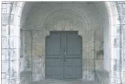
Porte Sud de la nef de l'église
