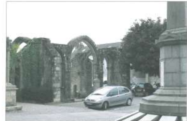
Vue générale des vestiges de la chapelle depuis la porte Sud de l'église.
