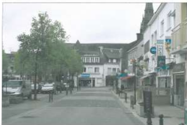
Côté Ouest et au Sud, maisons reconstruites au début du XX e siècle et après 1960
