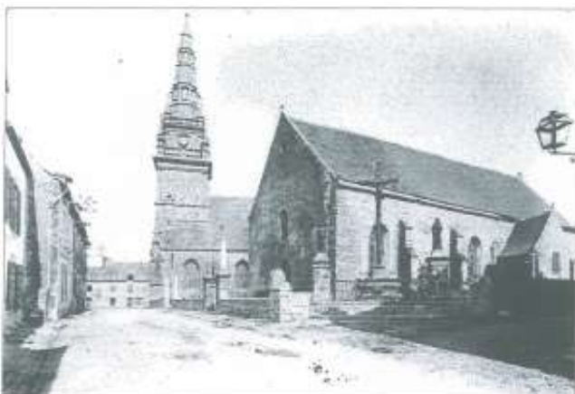
Vue générale Sud-Ouest du clocher de l'église paroissiale et de la chapelle Notre-Dame des Orties au début du XX e siècle (cliché Estève, Ministère de la Culture)
