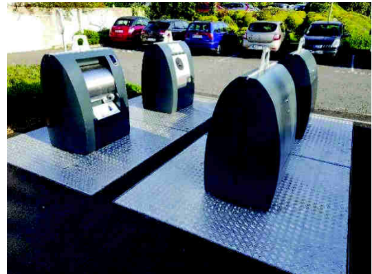
Colonnes enterrées. Quiberon
