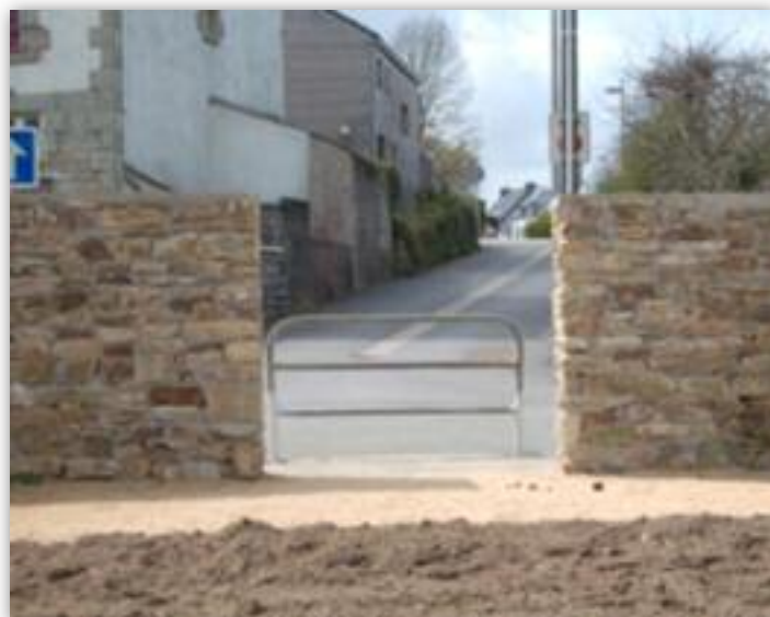
Ouverture de l'espace Saint-Michel vers les écoles et la salle Le Borgne.
