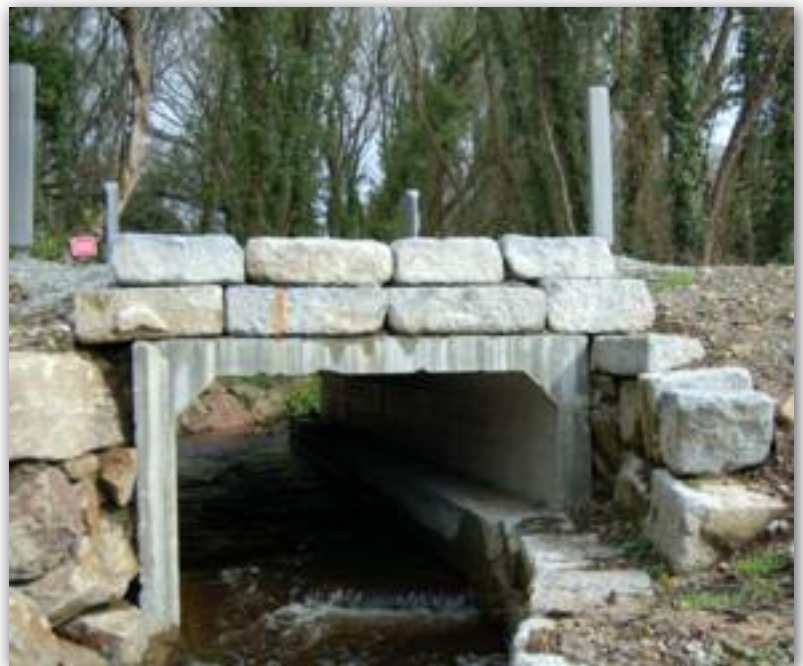
Le Pont de Kervily permet aussi le passage des loutres.
