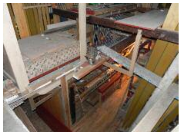
Vue plongeante du soubassement et du 1 er étage de l'orgue (il y en aura un 2 ème ). On aperçoit sur la droite le départ de grands tuyaux en bois qui attendent leur positionnement.
