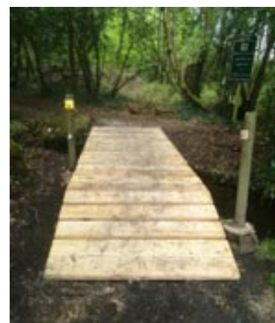
Chantier participatif des Farfadets et de la municipalité sur le chemin de Kervic
